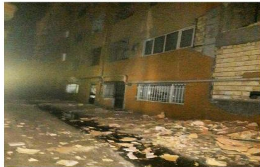
شکل ۴-۱۵: ریزش نمای ساختمان بر روی خودرو در جوانرود کرمانشاه
