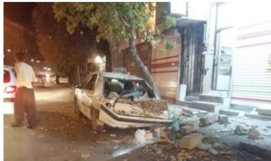
شکل ۴-۱۵: ریزش نمای ساختمان بر روی خودرو در جوانرود کرمانشاه
